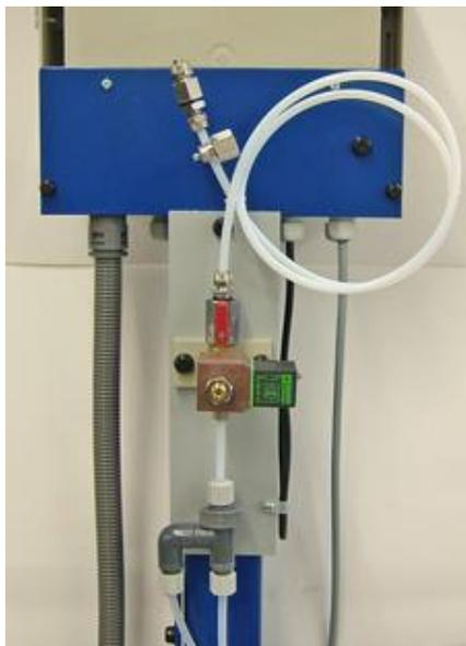
Abb. 2: Praher Pneumatikventile in der Zuleitung (von hinten rechts) und der Dosierleitung (links)
